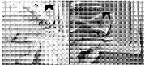
**i** Rassurez-vous que les segments de plinthes se trouvant sous le boîtier de la table de cuisson sont comblés avec du mastic.
